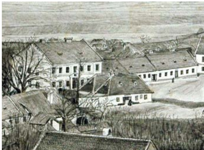
Boření Deutschova domu v roce 1931, v pozadí průčelí školy
