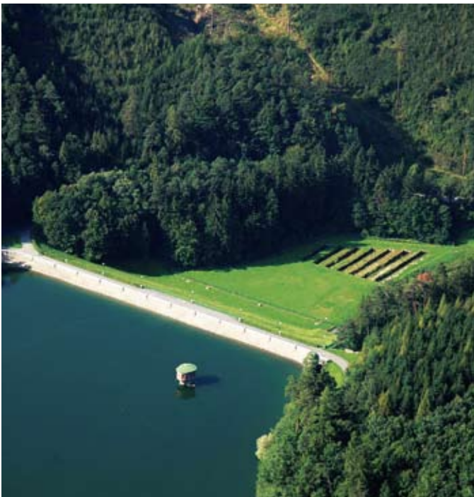
> Díky vodní nádrži Koryčany může být Kyjov zásobovaný pitnou vodou
