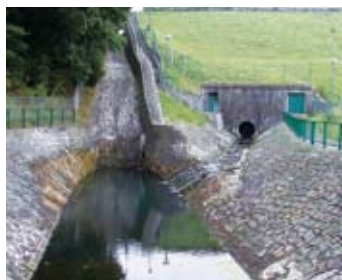
> Hráz je postavená z několika různých materiálů, taková metoda byla v době stavění unikátní
